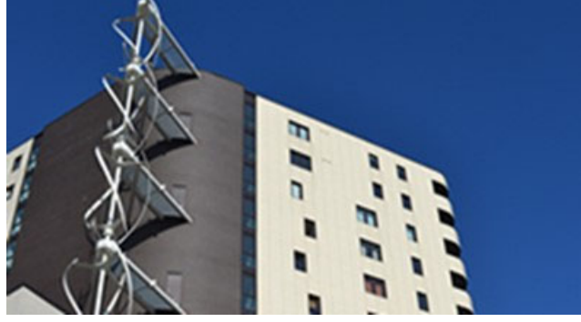
Şekil 7. Ramsgate Kinetica Binası [27]
