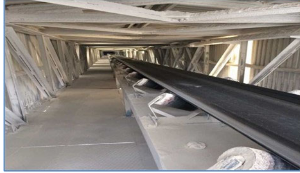
Şekil 2. Kardemir A.Ş. tesisi konveyör bant galerisi [11].
