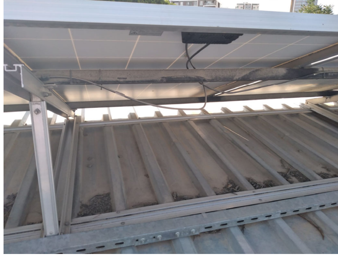
Şekil 6: Güneş Panelinin arkası ve panelin arkasına takılan akıllı cihaz.
