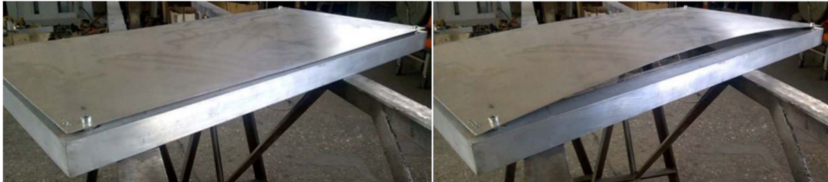
Resim 1. Formentini ve Lenci tarafından üretilen cephe elemanının açık ve kapalı halleri.
